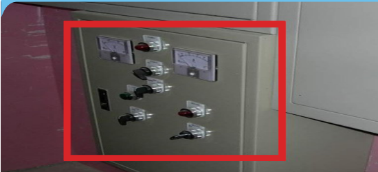
기계실 조작 분전반 전압표시 램프고장 (분전반 작동 확인 불가)
