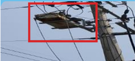
수전설비 인입개폐 설비 ASS(자동고장 구분개폐기) 부식 및 노후 (정전 발생 위험)
