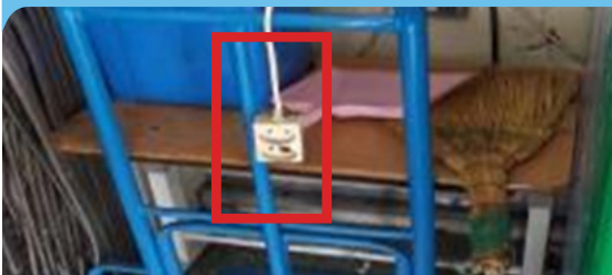
학교매점옆미사용노후콘센트방치및콘센트미고정사용 (노후 콘센트 사용 시 화재, 감전 우려)
