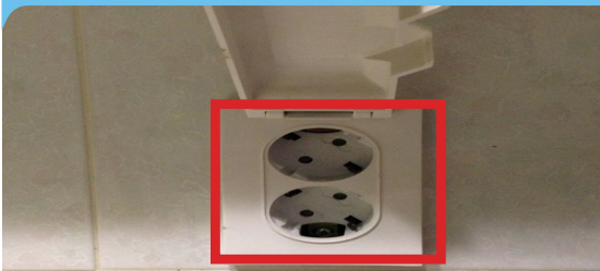
콘센트 내부 안전커버 미사용 (저학년 학생의 경우 젓가락 등 이물질을 투입하여 감전사고 위험 우려)
