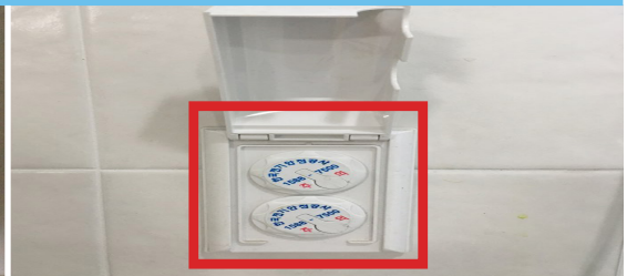
방수커버 안에 콘센트 안전커버를 모두 설치
