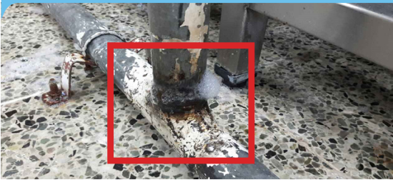
바닥배관 용접연결부 가스 누출 (화재 발생 위험)
